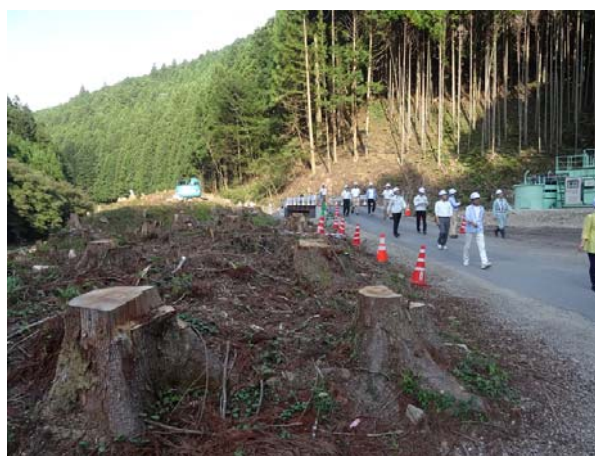
図17 ダムサイト建設地の様子（転流工 呑口部周辺）
