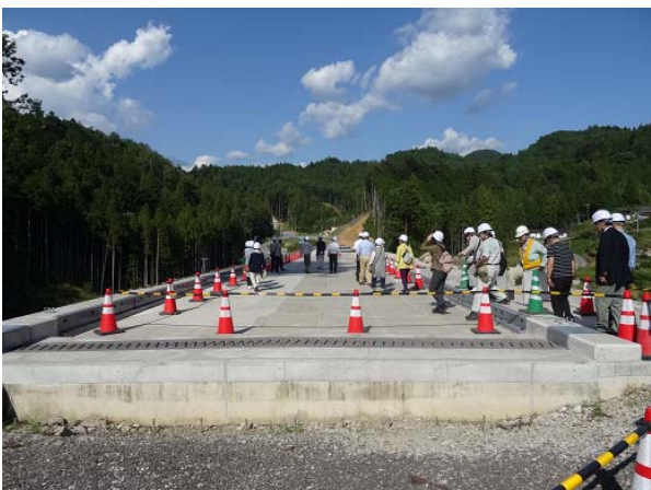
図 15 付替道路設楽根羽線 2号橋上部工の様子
