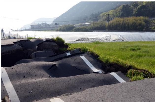
図5 木之内農園内農道の被害状況
