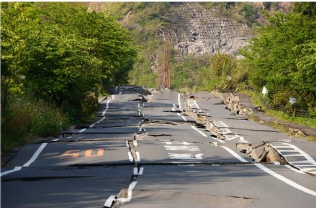
図 12 幹線道路の被害状況
