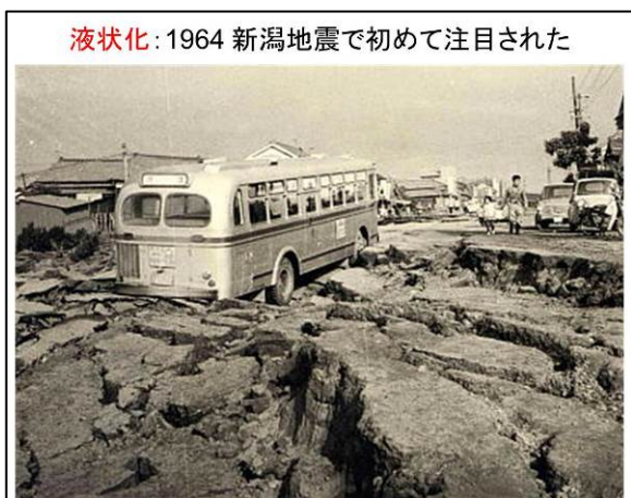
図 17 液状化：1964 年新潟地震で初めて注目された
