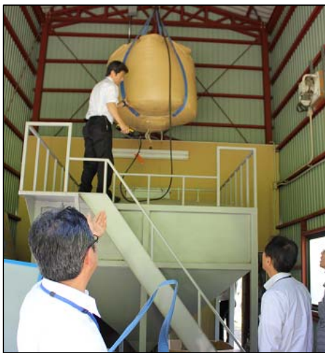
図 12 燃料サイロにペレットを投入する様子
