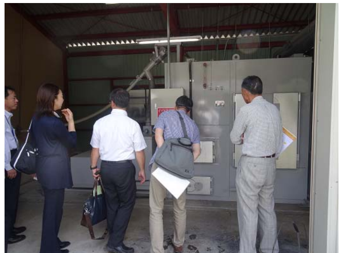
湯〜らんどパルとよね(ペレットボイラー)
