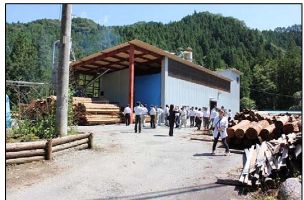
図5 ペレット工場の外観
