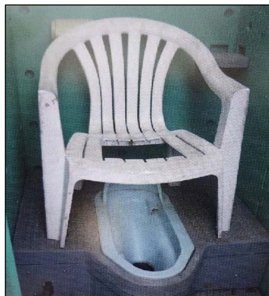
図 41 いすの座面をくり抜いて洋式トイレに！
