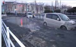
車道における噴砂状況 [第3回浦安市液状化対策技術検討調査委員会資料、平成23年7月、浦安市より引用]
