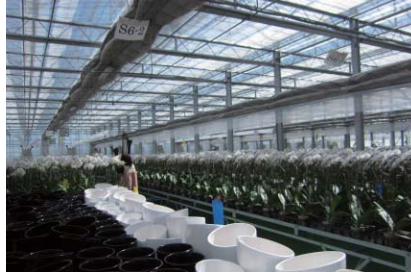
■ 外部遮光/ガラス/内部遮光/シルバーカーテン/ビニールの5層構造
