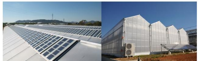
◆低炭素社会の実現に向け、天窗ソーラーパネル、二重皮膜、LED、ヒートポンプ、複合環境制御を導入
